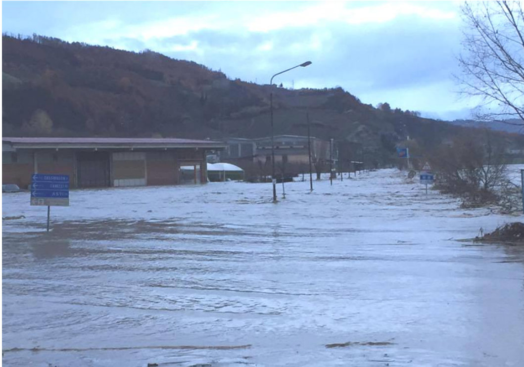
Fotografia 3: SP25 allagata in corrispondenza dell'Officina Meccanica Passalacqua e dello stabilimento industriale Valbormida S.p.A.
