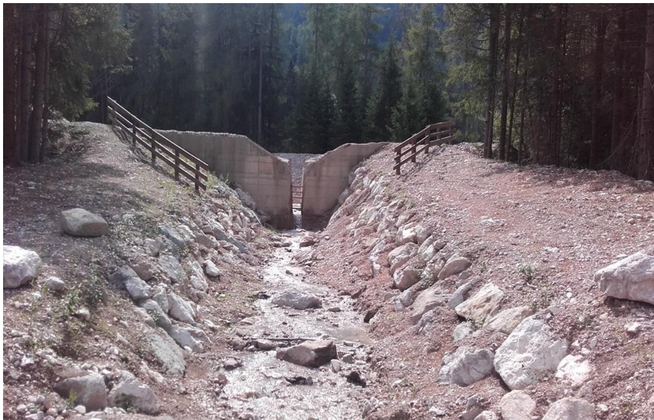
Figura 14: Risultati di un recente intervento di pulizia di una briglia di contenimento filtrante.
