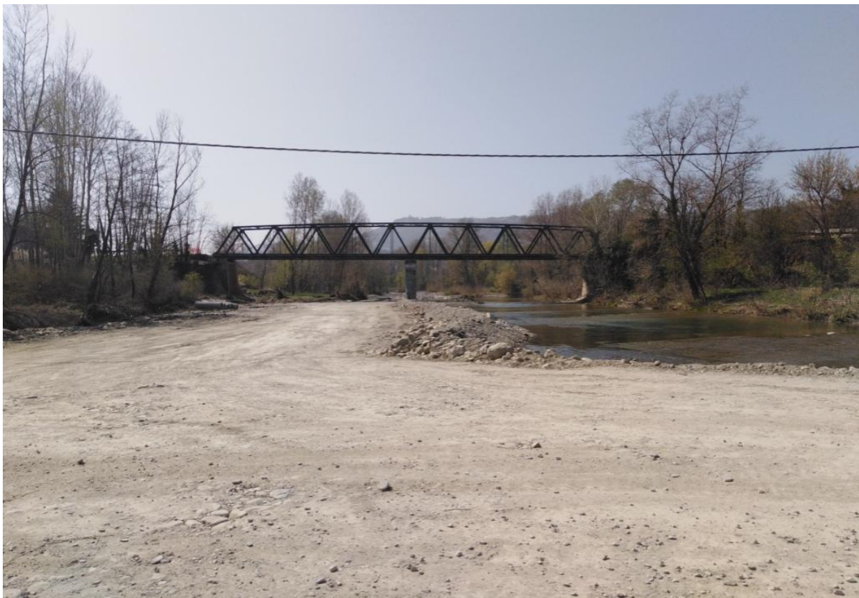
Figura 15: Creazione di una pista lungo un torrente appenninico.
