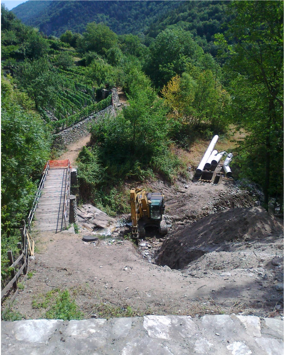
Figura 4: Intervento in alveo
