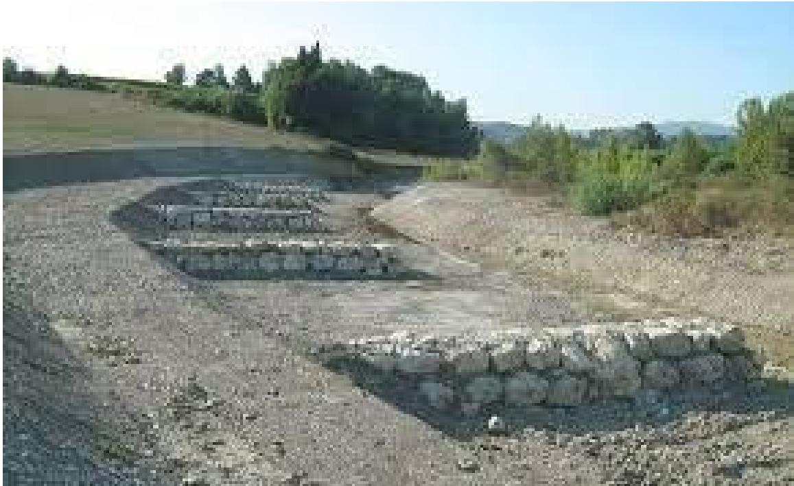
Figura 8: Disposizione di pennelli in massi per la correzione di una erosione spondale.
