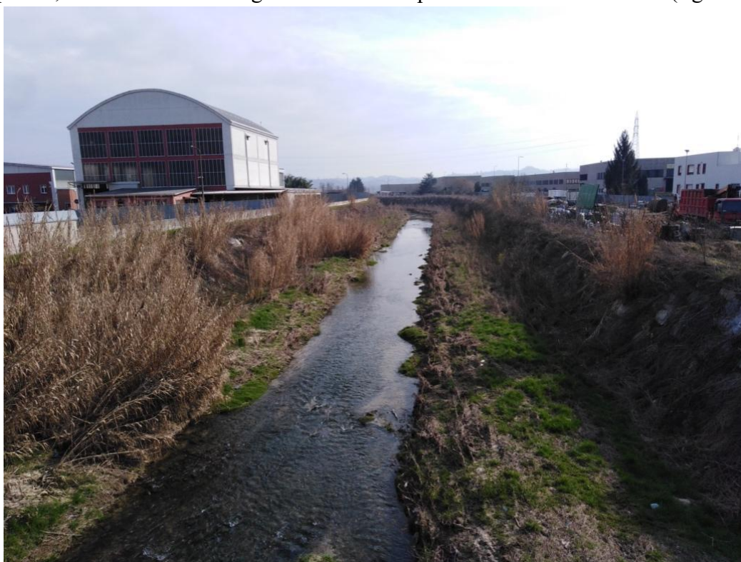
Figura 2: Un tratto di corpo idrico rettificato e privato della naturale vegetazione spondale.
