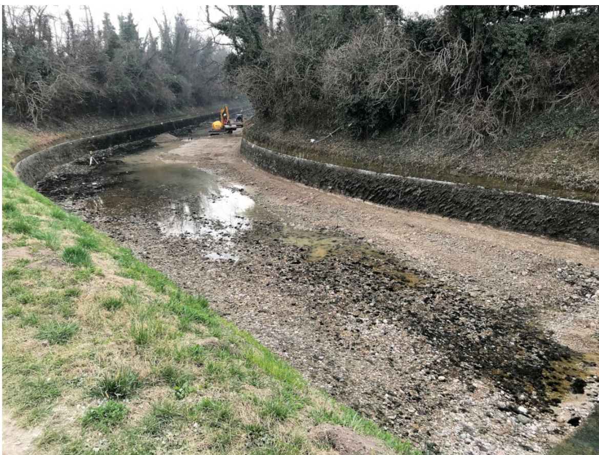
Figura 5: Un canale artificiale (a scopo irriguo) in fase di asciutta.
