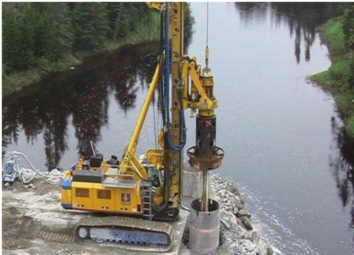
Figura 9: Formazione di pali di fondazione in alveo.
