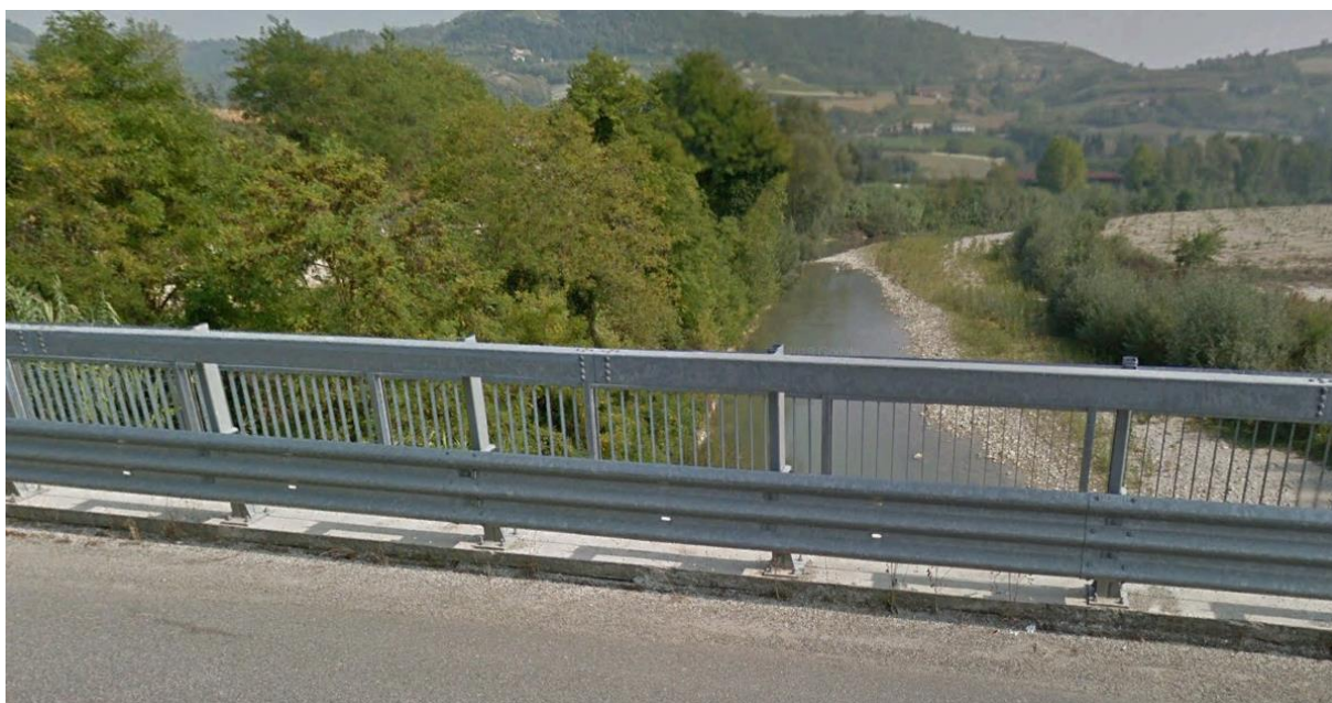
Fotografia 1 – Fiume Bormida di Millesimo visto dal ponte di via Fontanetta verso valle
