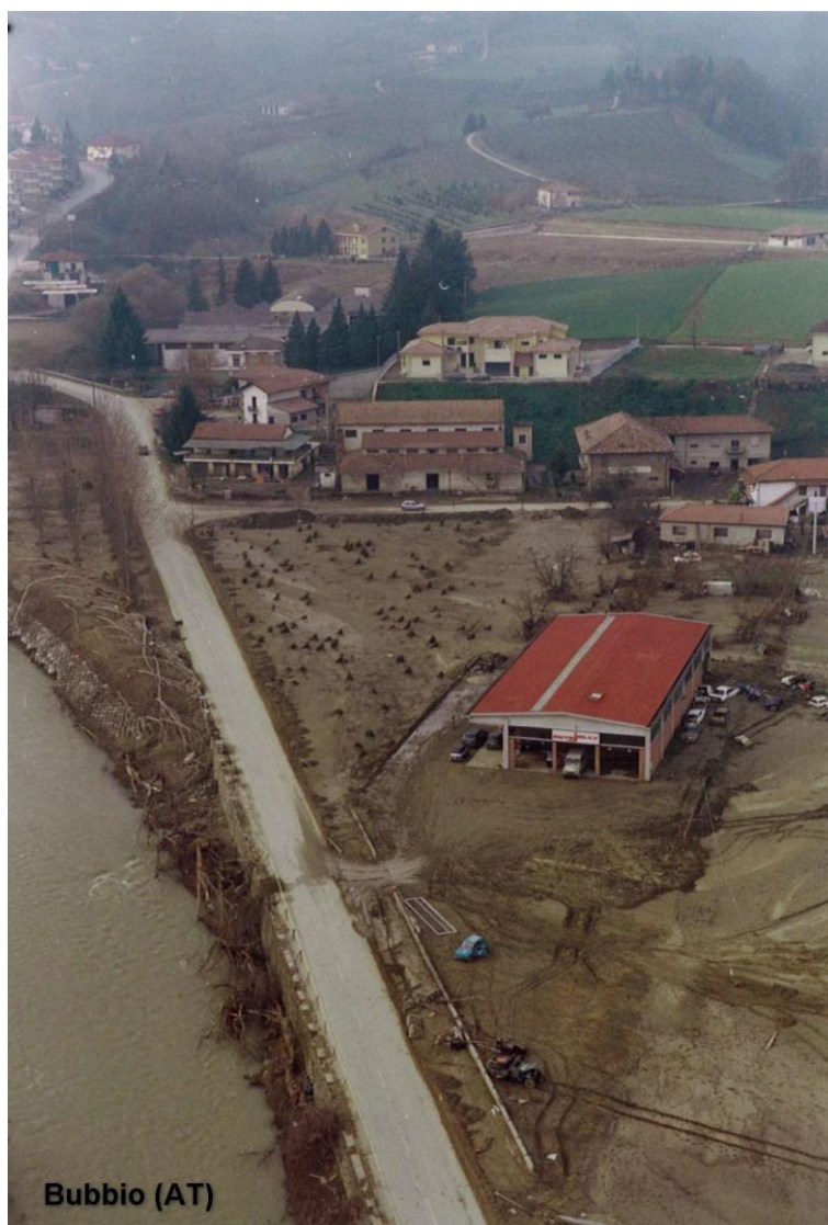
Figura 4.5: Foto aerea lungo la S.P. 25 dopo l'evento alluvionale del 1994
