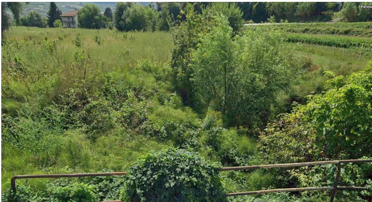
Fotografia6–Vista verso valle del rio San Pietro dal ponte in Regione Giarone
