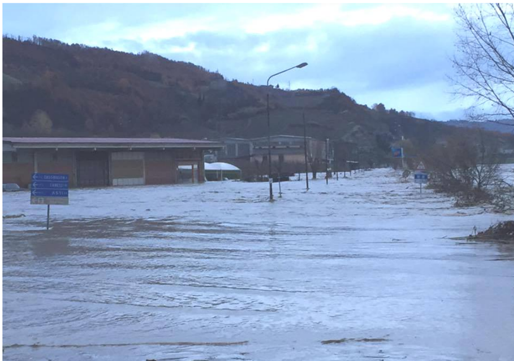
Fotografia 3: SP25 allagata in corrispondenza dell'Officina Meccanica Passalacqua e dello stabilimento industriale Valbormida S.p.A.
